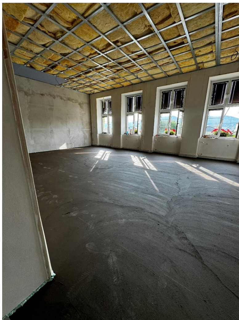
Obr. 5 – Rekonstrukce učebny – tančírna
